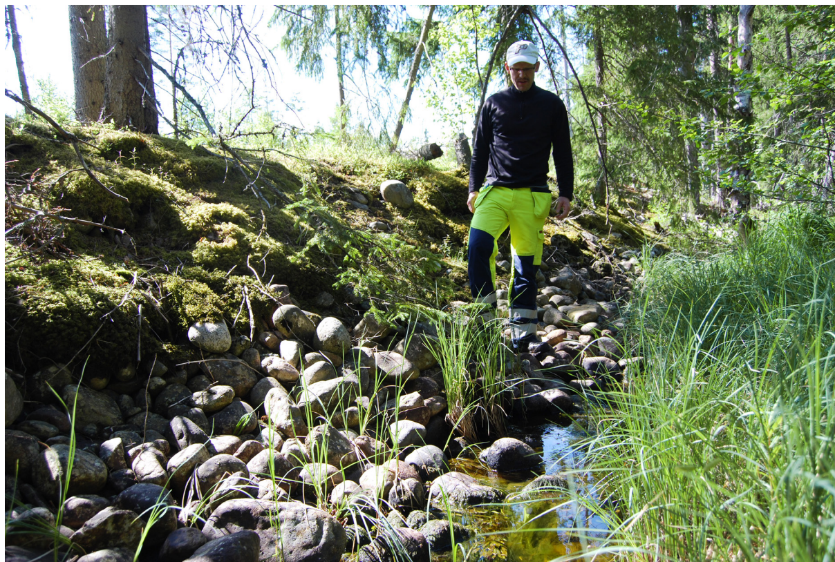
Figur 2. Grundvattenutläckage ur grovt isälvsmaterial i kanten av Sandån. Foto: Magdalena Thorsbrink.
