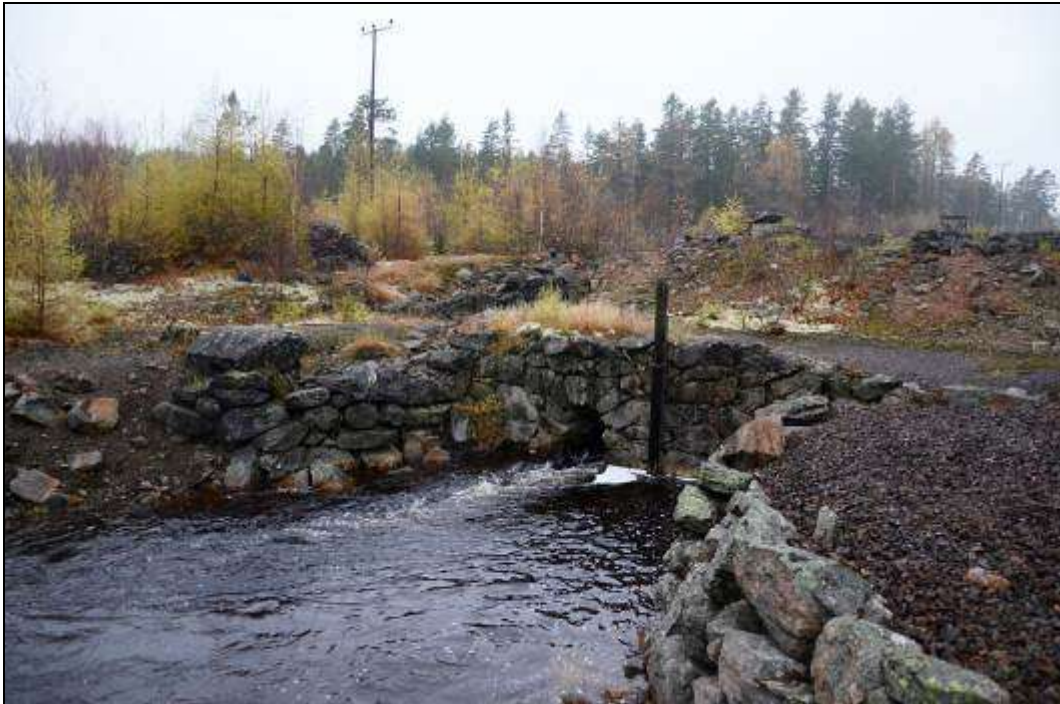
Figur 125. Nya Kopparverket. Nedströms damm nummer 4. Foto mot nordväst.
