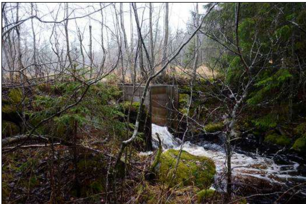
Figur 25. Brädfodrat utskov från Stora Sörsjön. Foto mot sydväst. Genom utskovet har timmer flottats till ångsågen vid Klothyttan
