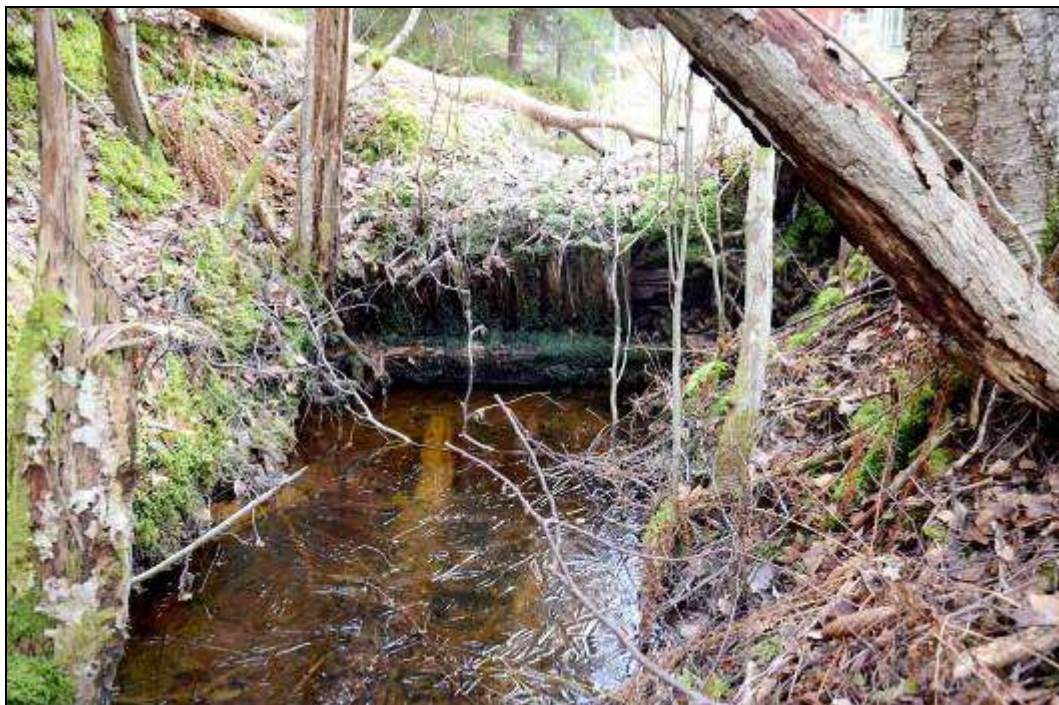
Figur 76. Detalj av dammkonstruktionen med jordfylld träkiskta. Foto mot norr.
