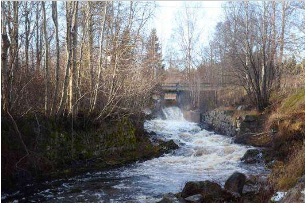
Figur 55. Damm med körbro över Hedströmmen vid den plats som idag kallas Nedre Borgfors. Foto mot väster.
