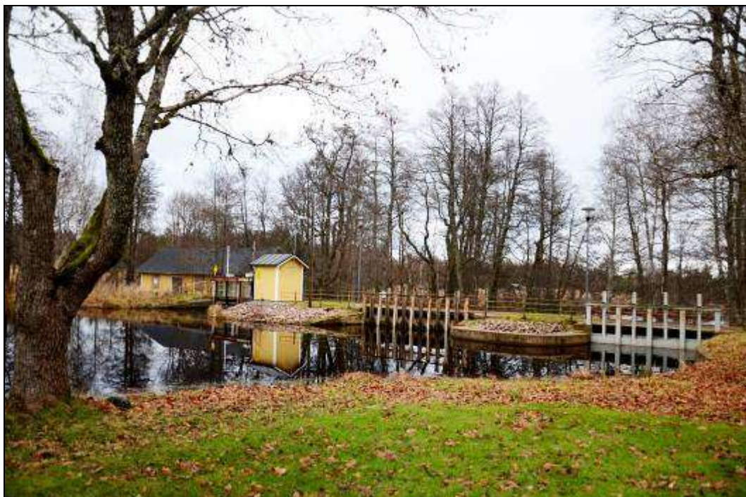
Figur 215. Uttersbergs bruk. Dammanläggningen. Foto mot sydöst.
