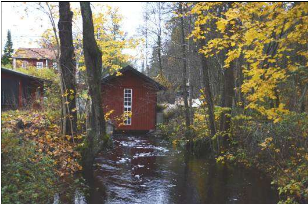
Figur 282. Turbinhuset vid Kedjebohammar. Foto uppströms mot norr.
