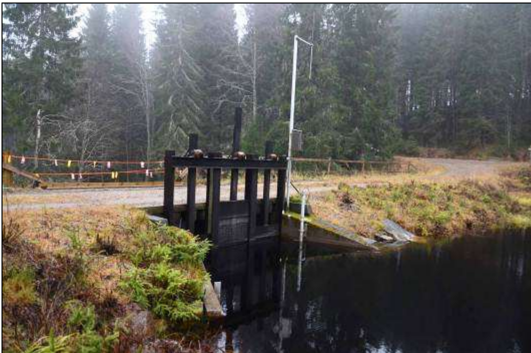
Figur 19. Dammen fungerar även som bro över vattendraget. Foto mot sydväst.
