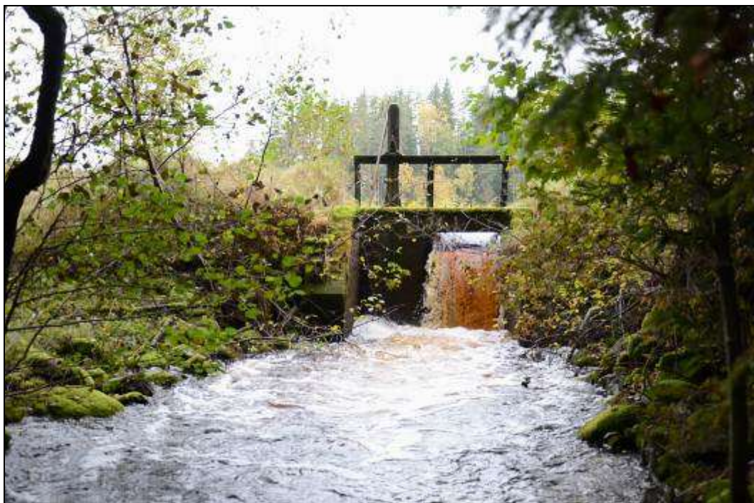
Figur 208. Dämnet vid Nedre Gävjans utlopp. Foto mot väster.
