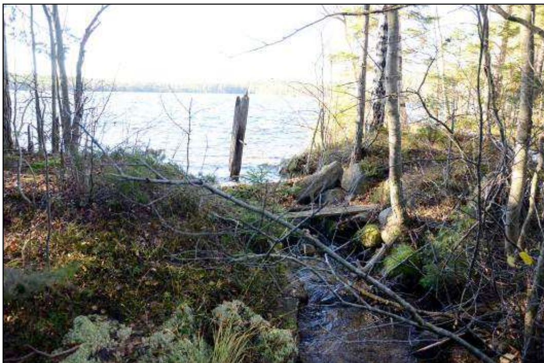
Figur 81. Västra Skälsjöns utlopp med öppning i dammvallen. Foto mot väster.
