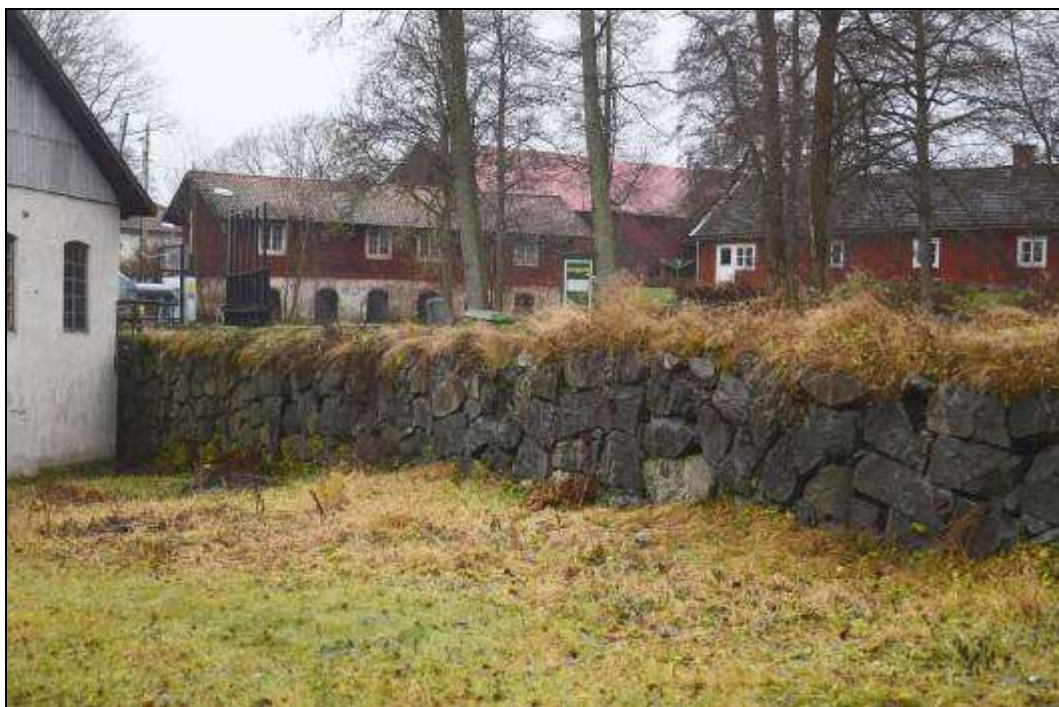
Figur 335. Del av dammanläggningen vid Karmansbo. Foto mot väster.
