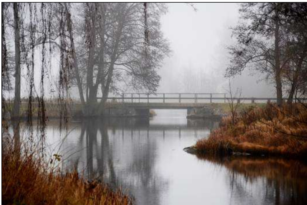
Figur 307. Nyare bro vid äldre överfart över Gunnilboån uppströms kraftverksdammen. Foto mot nordöst.
