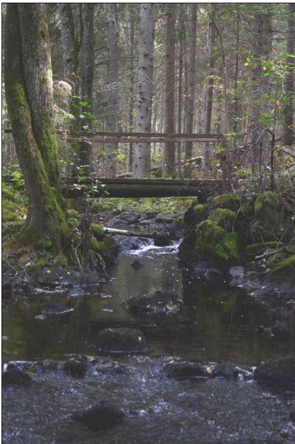
Figur 291. Återanvänt äldre brofäste vid Österflena hammare. Foto mot öster.
