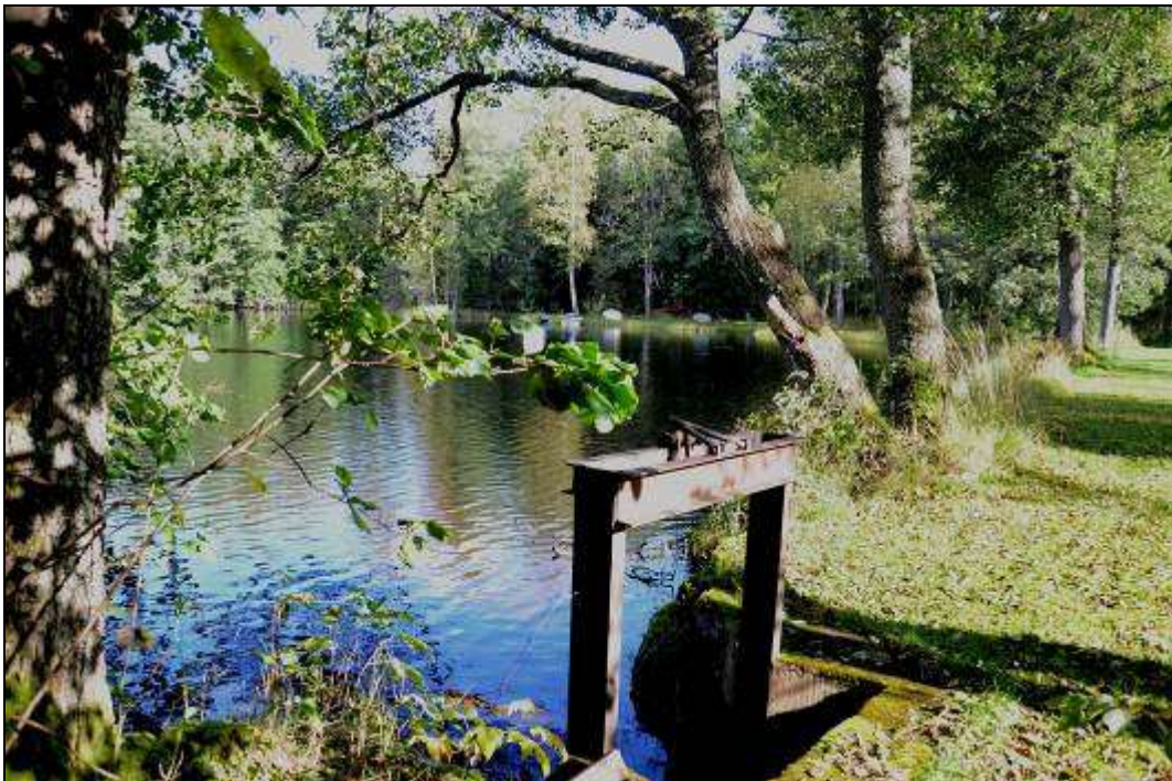
Figur 233. Utskov vid Damsjöns södra utlopp (Västervåla 80:1). Foto mot nordöst.
