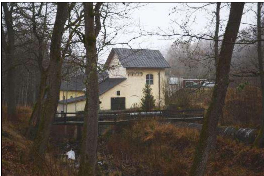
Figur 308. Turbinhus vid Färna på åns västra sida. Foto mot sydväst.
