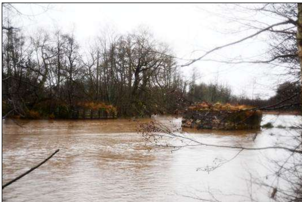
Figur 392. Kallmurat brofundament mitt i Hedströmen. Foto mot norr.
