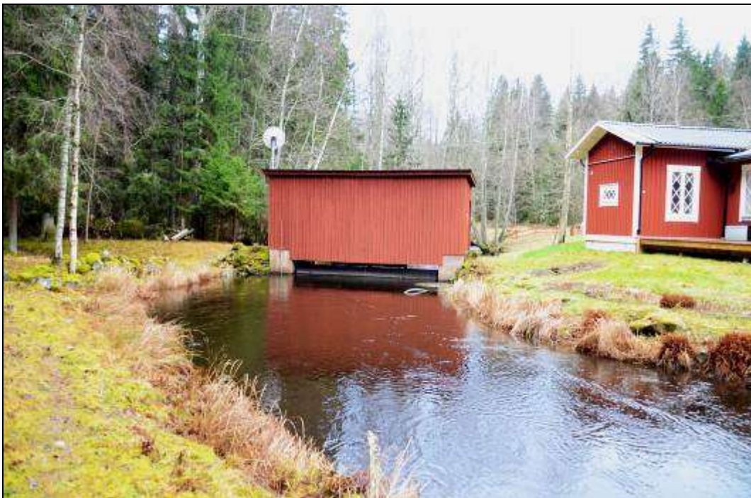
Figur 349. Mindre kraftverk vid Åholmen som utgör ett utpekat vandringshinder för fisk. Foto mot söder.
