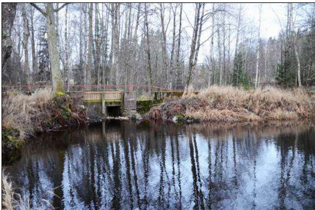
Figur 366. Uppströms tegelbruksdammen. Foto mot söder.
