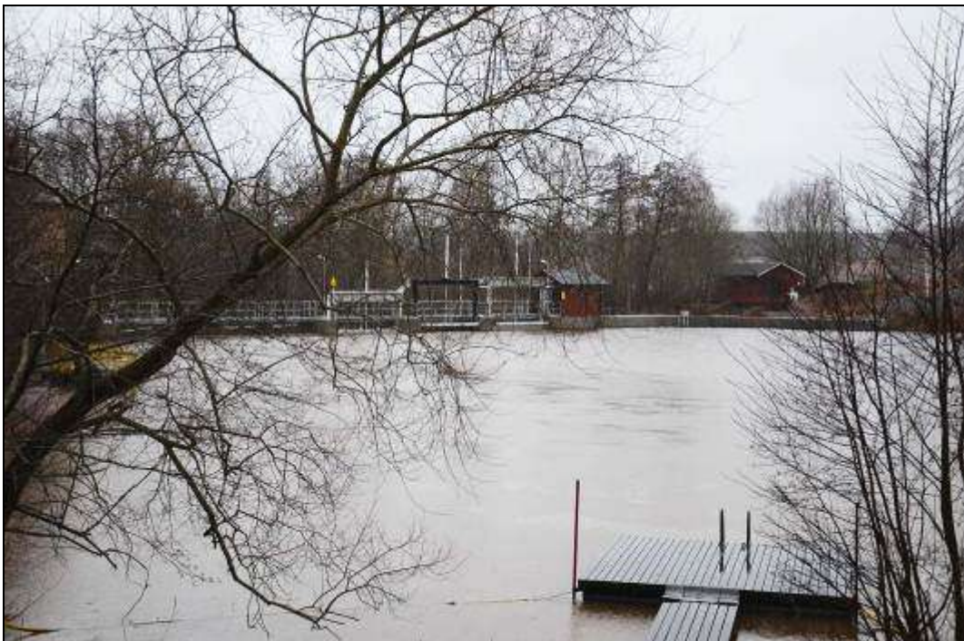
Figur 380. Lyftingedammen. Foto mot söder.
