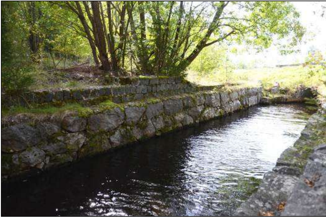
Figur 290. Kallmurad stenförstärkning av åfåran samt slaggstensgrund efter sågen vid Västra Flena. Foto mot väster.
