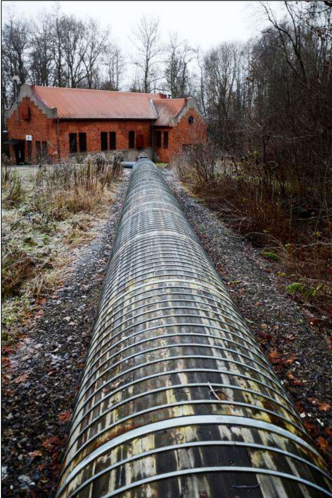
Figur 198. Trätub till kraftverket. Foto mot söder.
