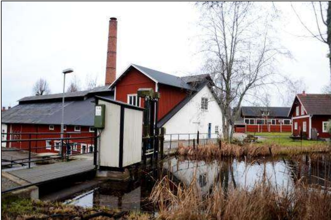
Figur 355. Läge för Gisslarbo Övre hammare (Kolsva 79:1), med den senare hammarsmedjan och valsverk. I förgrunden syns delar av nuvarande dammanläggning. Foto mot väster.
