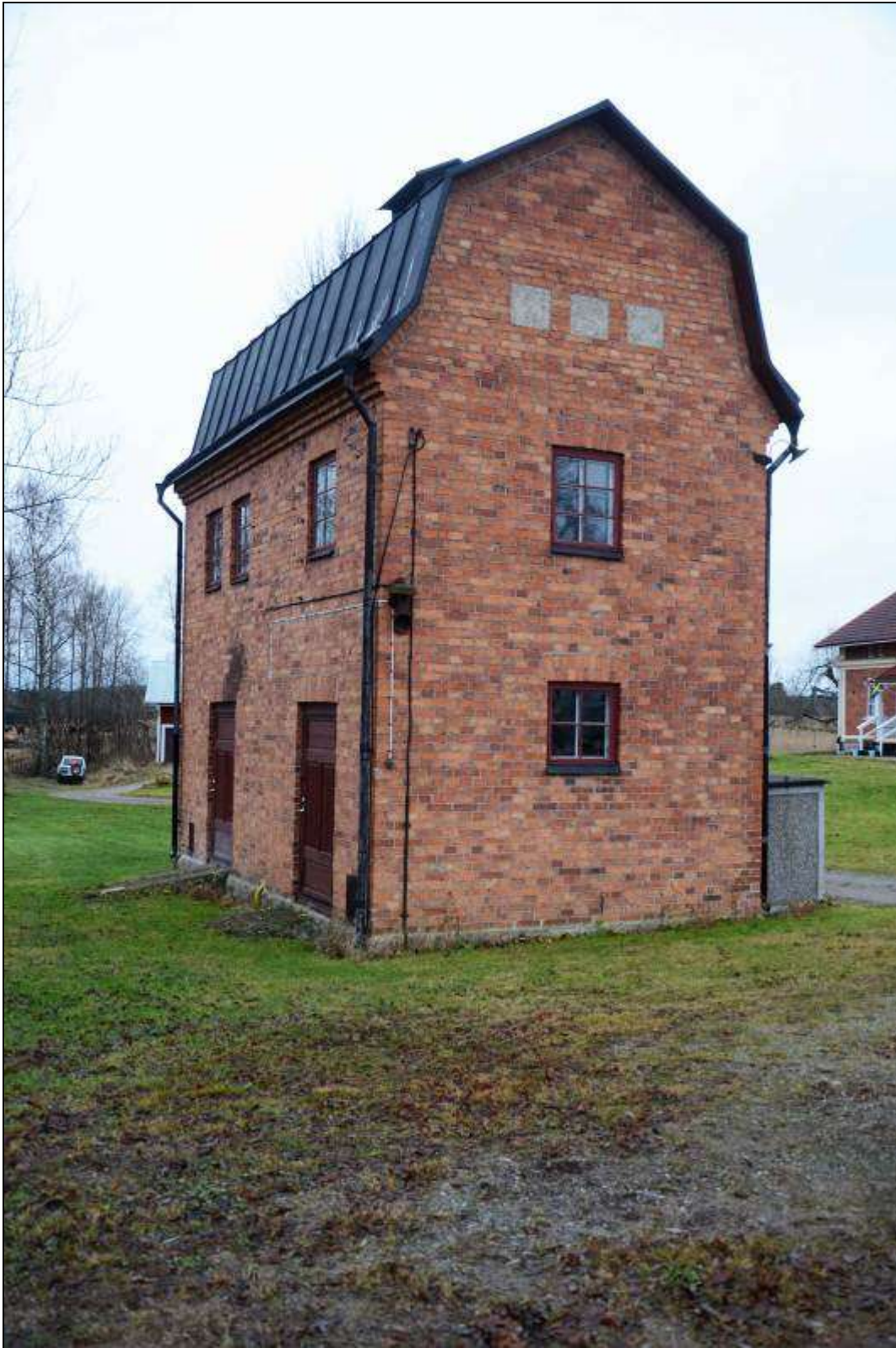
Figur 357. Tegelbyggnad som inhyst generator till den senare hammarsmedjan och valsverket.
