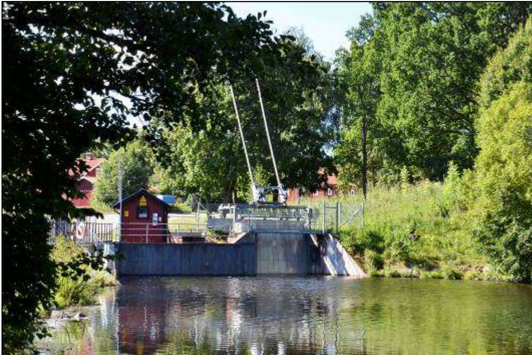
Figur 371. Nuvarande damm vid Kolsva Bruk. Foto mot sydväst.
