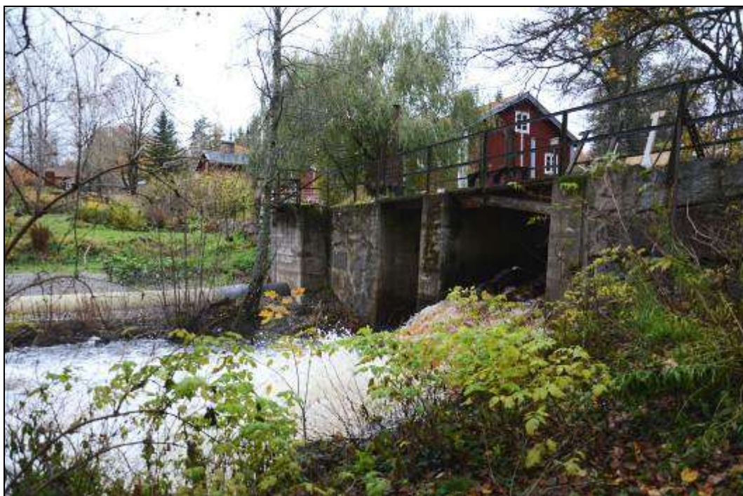
Figur 280. Dammen över Gunnilboån vid Kedjebohammar. Foto mot nordväst.
