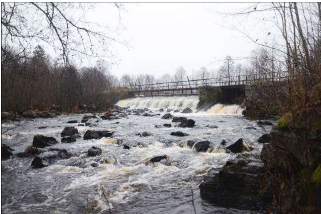
Figur 343. Nuvarande dammen vid Holmens Kraftstation. Foto mot norr.
