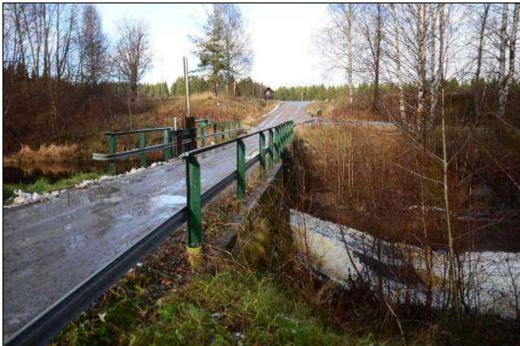
Figur 52. Den kombinerade dammen med körbro vid Nedre Borgfors. Foto mot norr.
