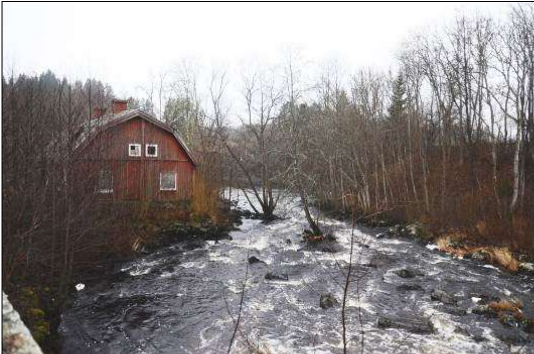
Figur 342. Hedströmmen vid Holmens Kraftstation. Byggnaden har en så kraftig stenfot att den kan vara byggd på den forna hammargrunden. Foto mot söder.
