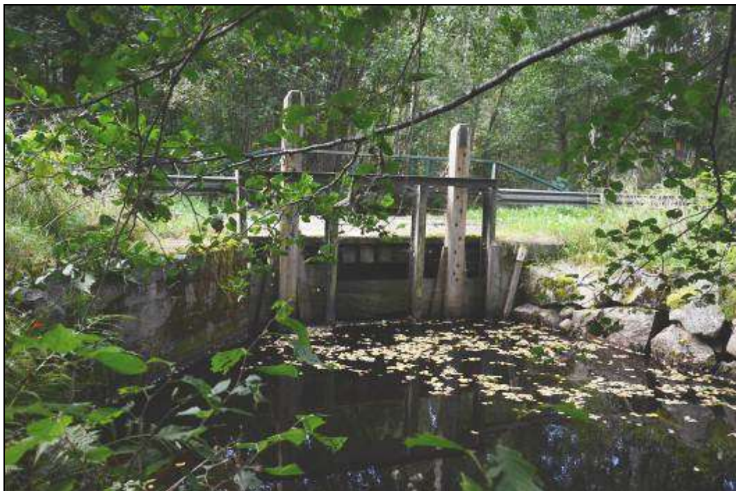
Figur 286. Kombinerad bro och dämme vid Flenassjöns utlopp. Foto mot väster.
