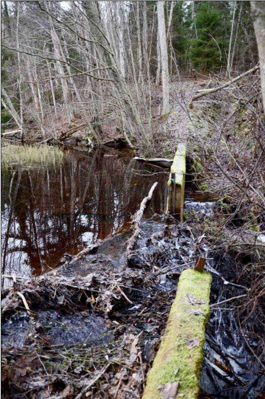
Figur 77. Senare bättring av dammens mittparti. I bakgrunden skymtar en äldre del av anslutningsdammen av jord och sten. Foto mot öster.
