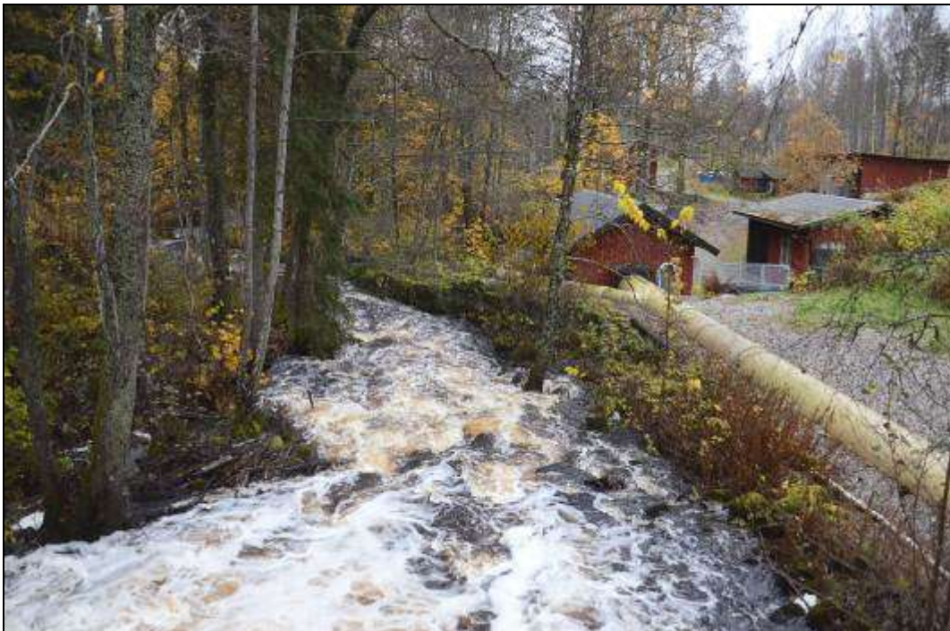
Figur 278. Nedströms Kedjebohammar. Till höger i bild skymtar vattentub och turbinhus. Foto mot söder.
