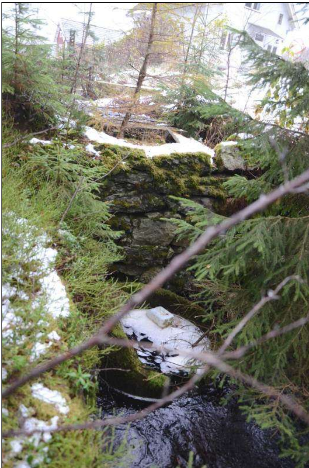
Figur 144. Kallmurat dämme i Persgruvviken. Grävd gruvkanal för processvatten till Bäckegruvan. Foto mot norr.
