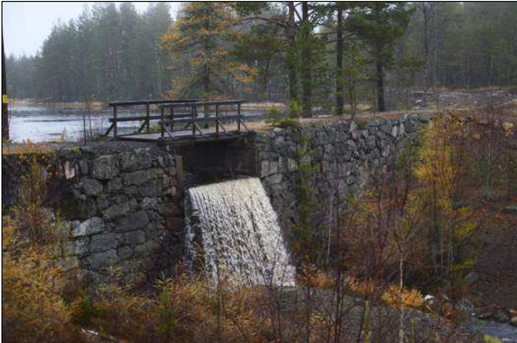
Figur 121. Övre dammen närmast Nedre Skärsjön. Foto mot nordöst.
