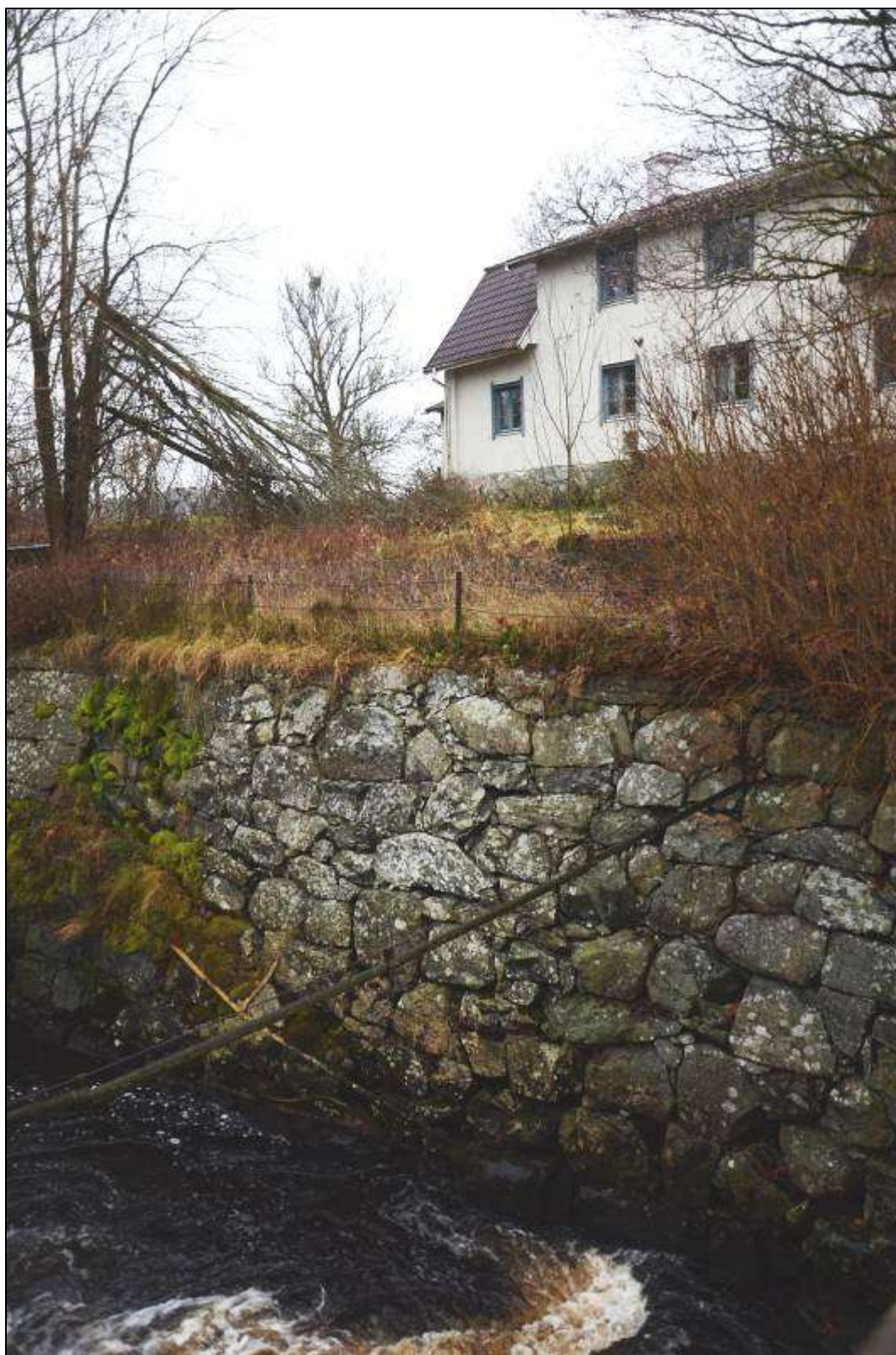
Figur 333. Detalj av kallmurad del av hammarområdet. Foto mot sydväst.
