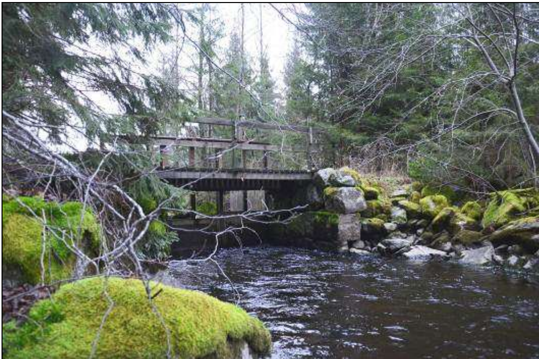
Figur 351. Registrerat vandringshinder för fisk i form av dammanläggning i den östra åfåran. På äldre lantmäterikarta från 1781 återfinns den som både damm och bro. Foto mot nordöst.
