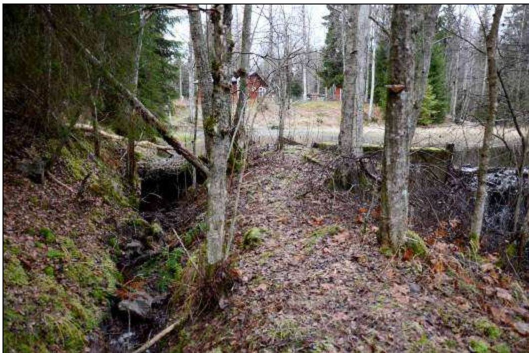
Figur 78. Bagghyttans damm i bakgrunden med grävd kanal till vänster. Foto mot norr.
