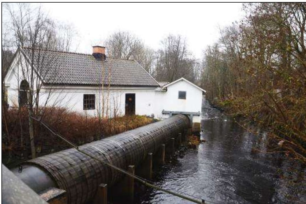
Figur 334. Vattentub och turbinhus nedströms kraftverksdammen. Foto mot söder.
