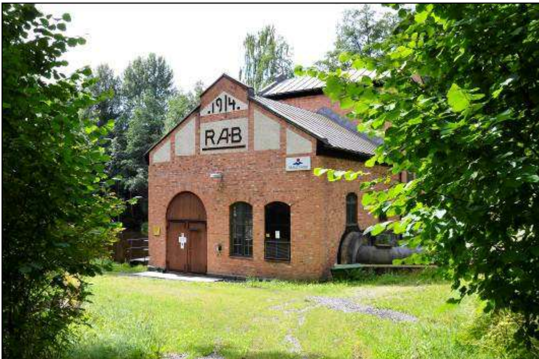
Figur 361. Gisslarbo kraftverksbyggnad. Anläggningen anlades 1914 i samband med att den övre hammarsmedjan moderniserades. Foto mot söder.
