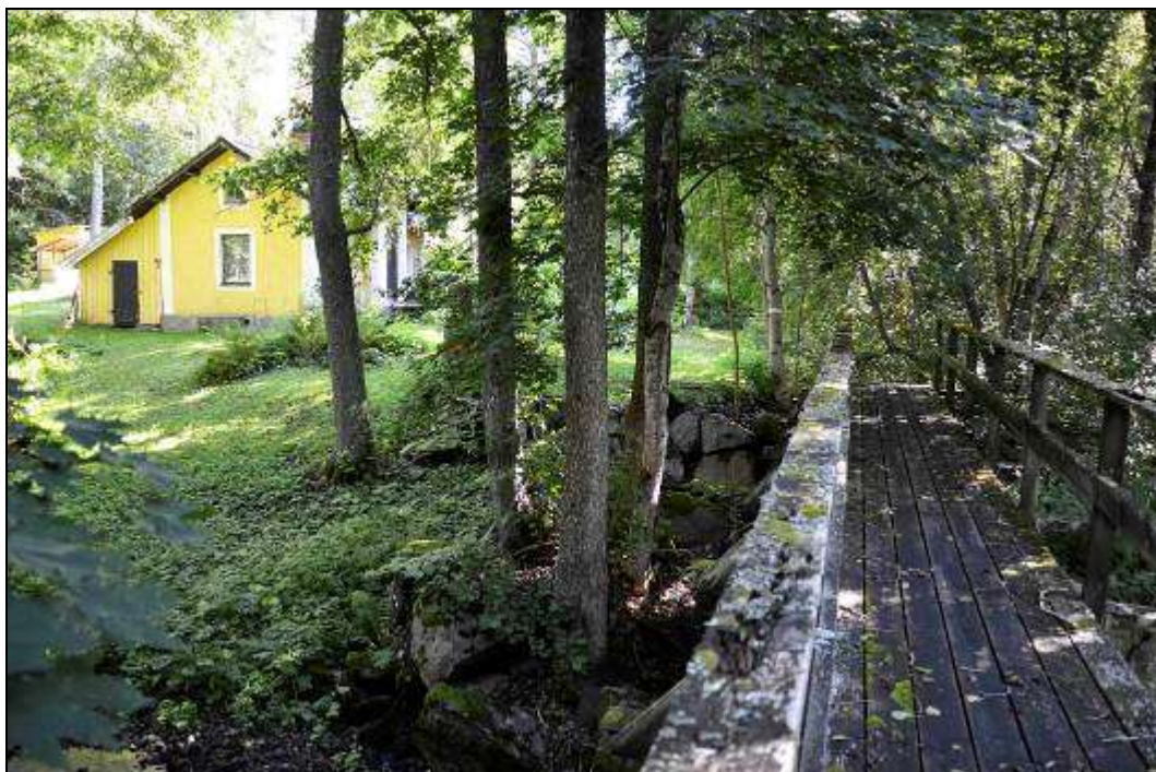
Figur 359. Gångbro över resterna efter dammen till Gisslarbo nedre hammare. Till vänster i bild anas en gulputsad byggnad där det enligt äldre kartmaterialet legat en smedsbyggnad. Foto mot öster.
