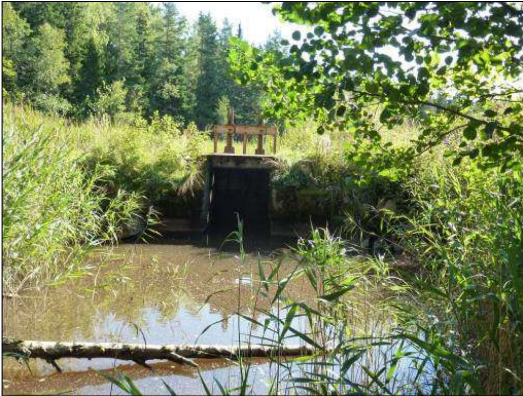
Figur 294. Nedströms dämnet vid sjön Långbjörkens utlopp ( Gunnilbo 72:1). Foto mot nordöst.
