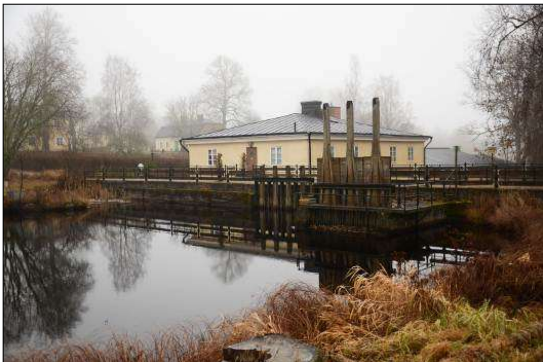
Figur 306. Nuvarande kraftverksdammen vid Färna. Foto mot sydöst.
