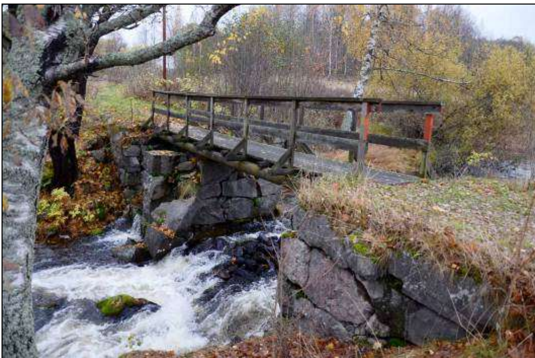
Figur 104. Registrerad fördämningsanläggning (Skinskatteberg 225:1) fungerar idag som gångbro över Darsbobäcken. Fördämningsanläggningen är troligen identiskt med den kvarn som omnämns på 1696 års geometriska karta. Observera hjulgraven längs bort och till vänster i bild. Foto mot norr.
