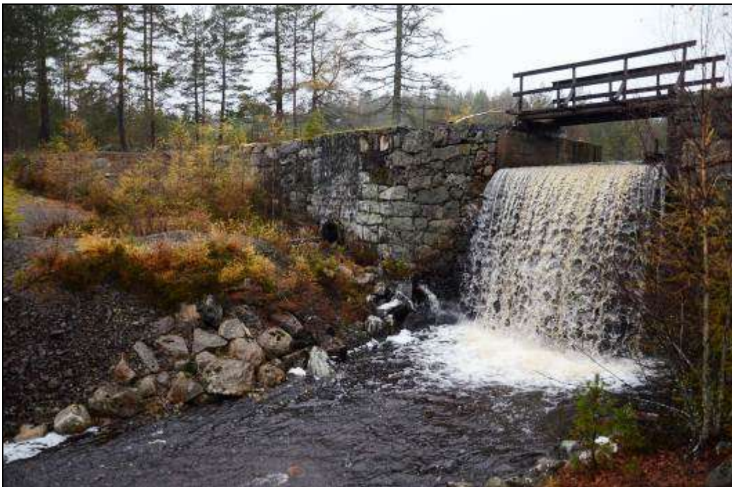
Figur 119. Övre dammen närmast Nedre Skärsjön, sedd nedströms. Foto mot nordväst.
