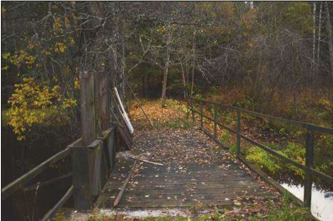
Figur 277. Kominerad damm och bro över Gunnilboån vid Kedjebohammar. Foto mot öster.
