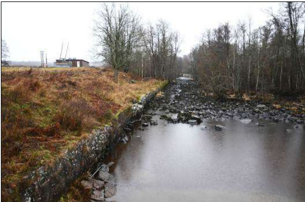
Figur 385. Stensatt strömfåra vid Hjulbron. I bakgrunden skymtar Ekeby kraftverk. Mot söder.
