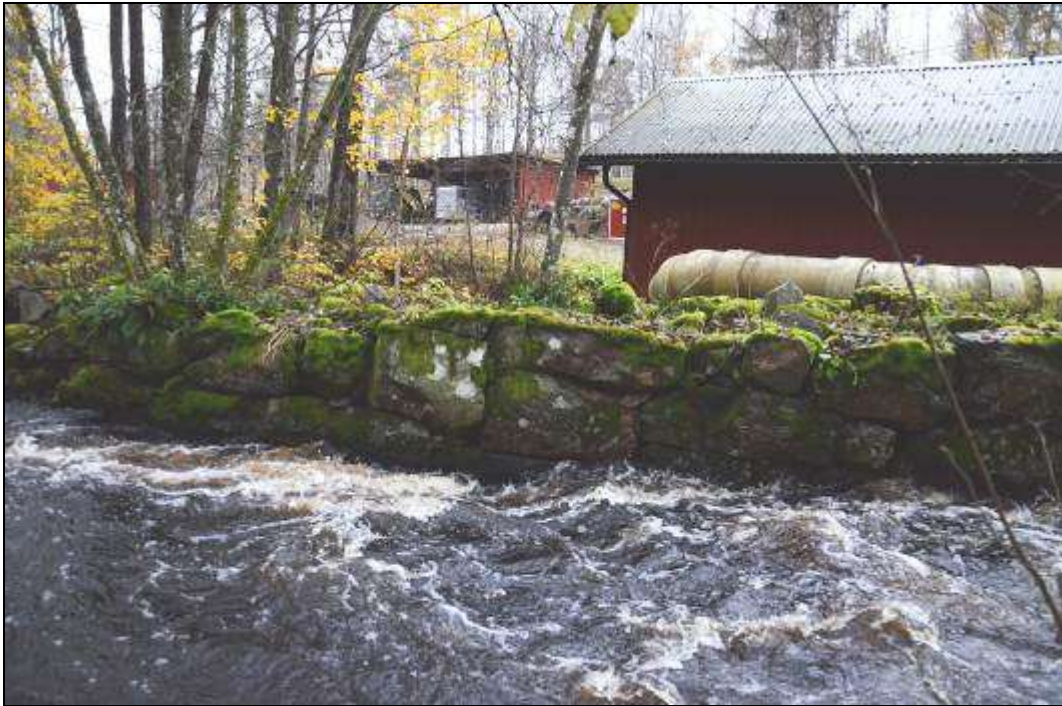
Figur 281. Förstärkning av den västra strömfåran nedströms dammen vid Kedjebohammar. Foto mot sydväst.
