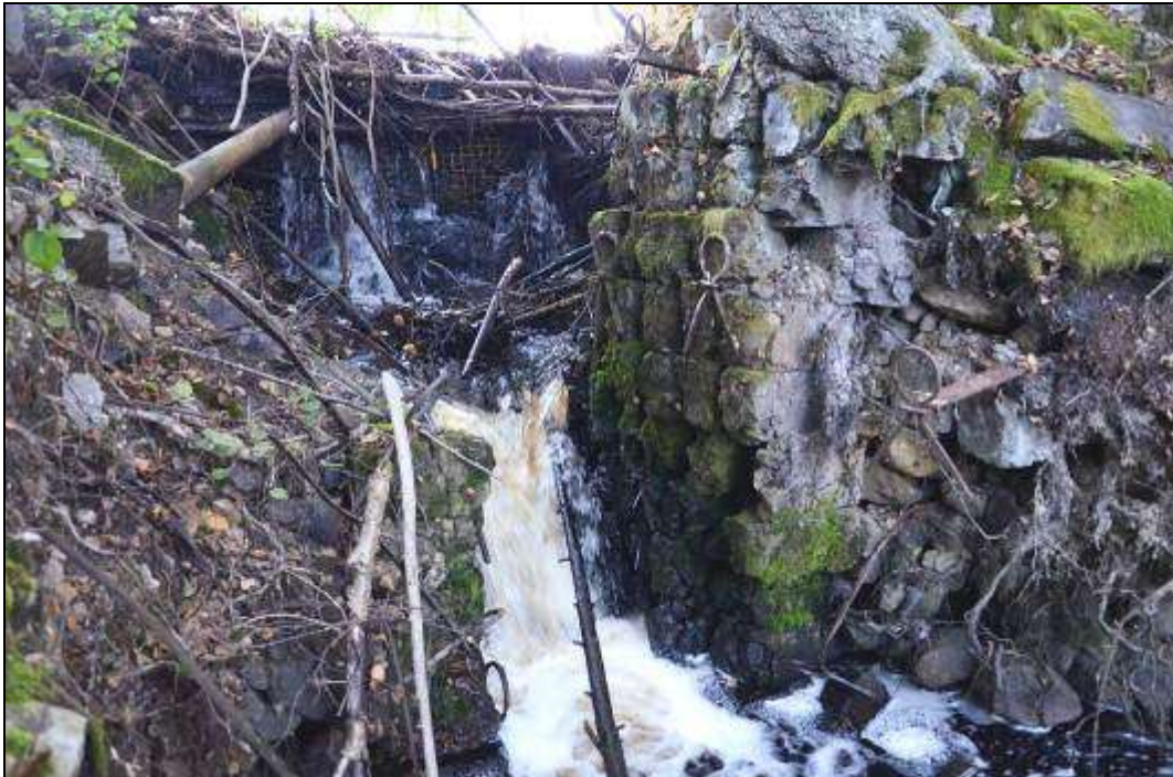
Figur 239. Detalj av dammvallen vid Sågsjöns södra utlopp (Västervåla 107:1). Notera utskovets konstruktion med gjutna slaggstenar sammanhållna av järnryttare. Foto mot norr.
