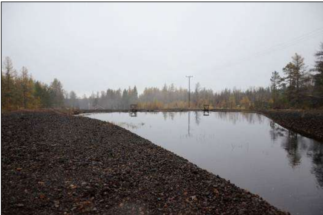
Figur 124. Nya Kopparverket. Upströms damm nr 3. Foto mot söder
