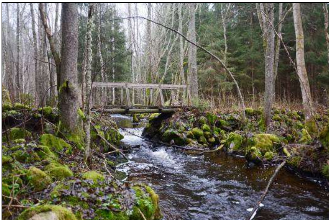
Figur 298. Broläggning över Gillbobäcken strax sydöst om bebyggelsen. Foto mot norr.
