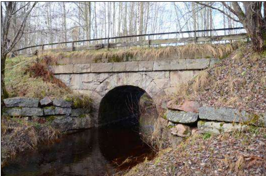
Figur 56. En stenvalvsbro som inte finns registrerad i FMIS. Foto mot nordväst.
