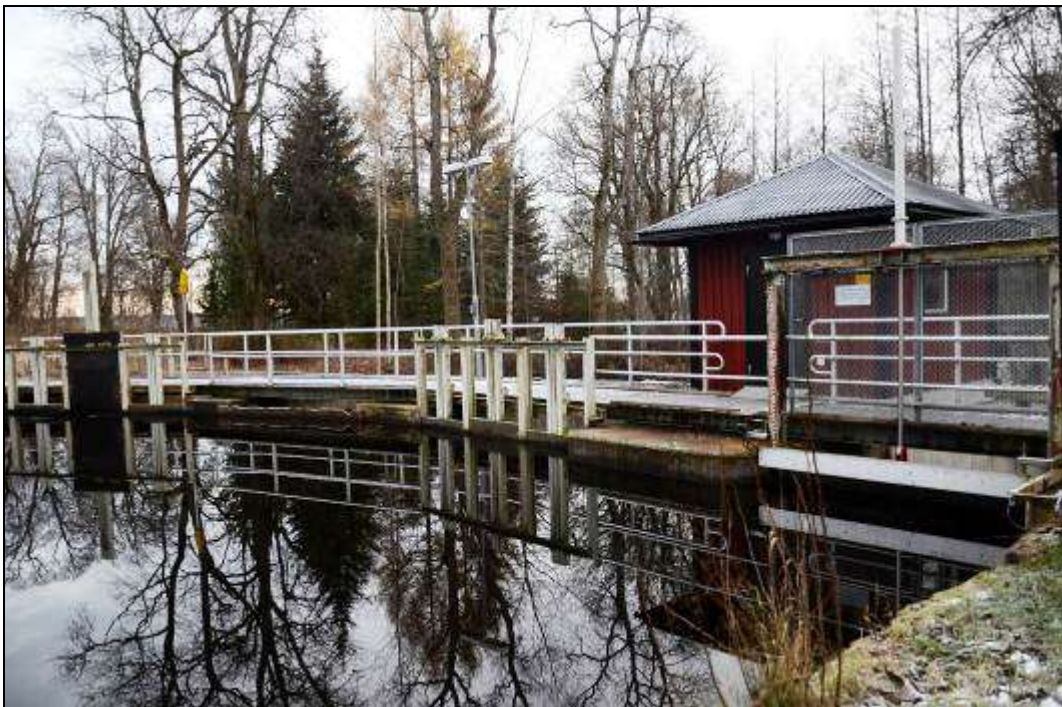
Figur 196. Kraftverksdamm. Foto mot sydöst.
