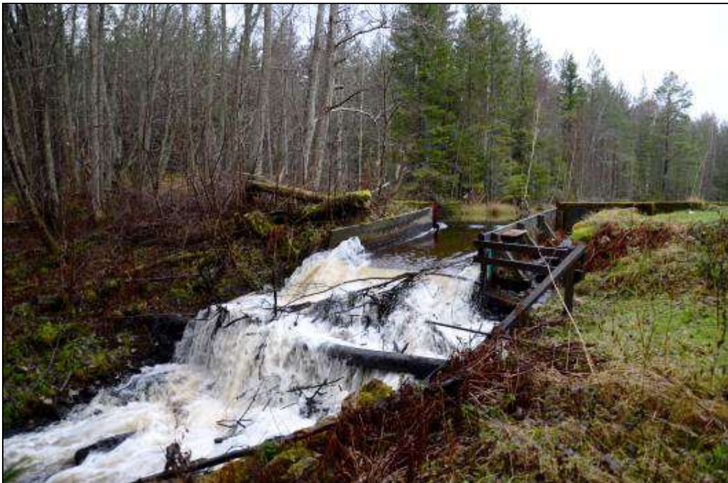
Figur 146. Övre Ugglefors. Vandringshinder nr1277. Foto mot nordväst.
