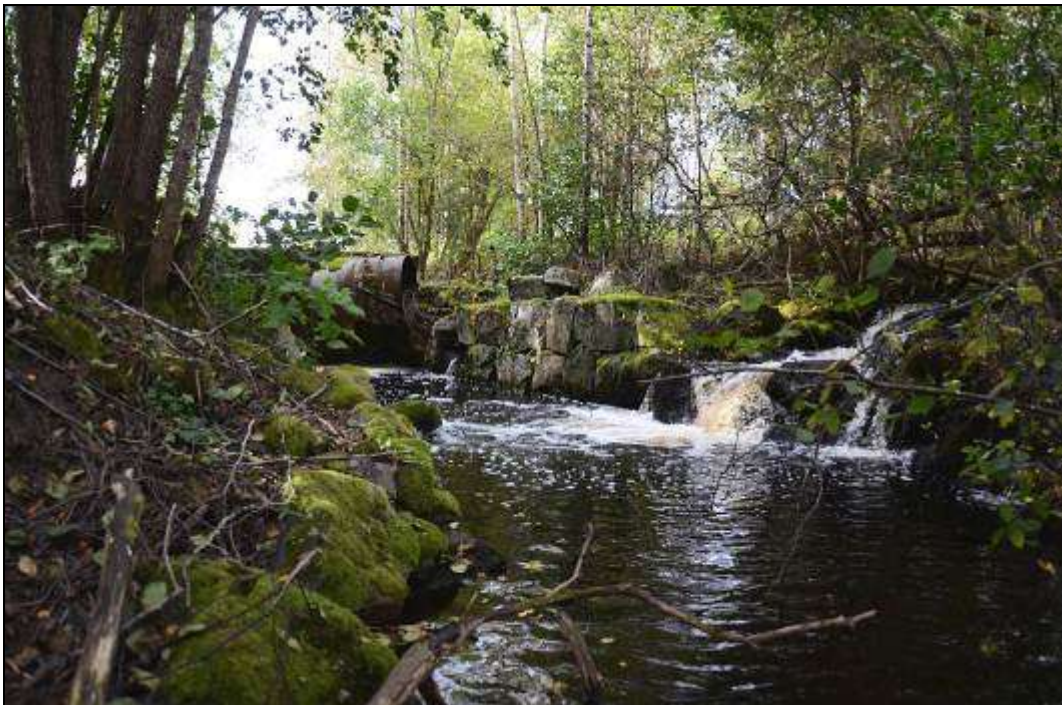
Figur 289. Lämningar efter sågen vid Västra Flena. I bakgrunden syns rester efter vattentub och utloppet från den kanal som grävdes mellan Flenasjön och Norrsjön. Foto mot västnordväst.
