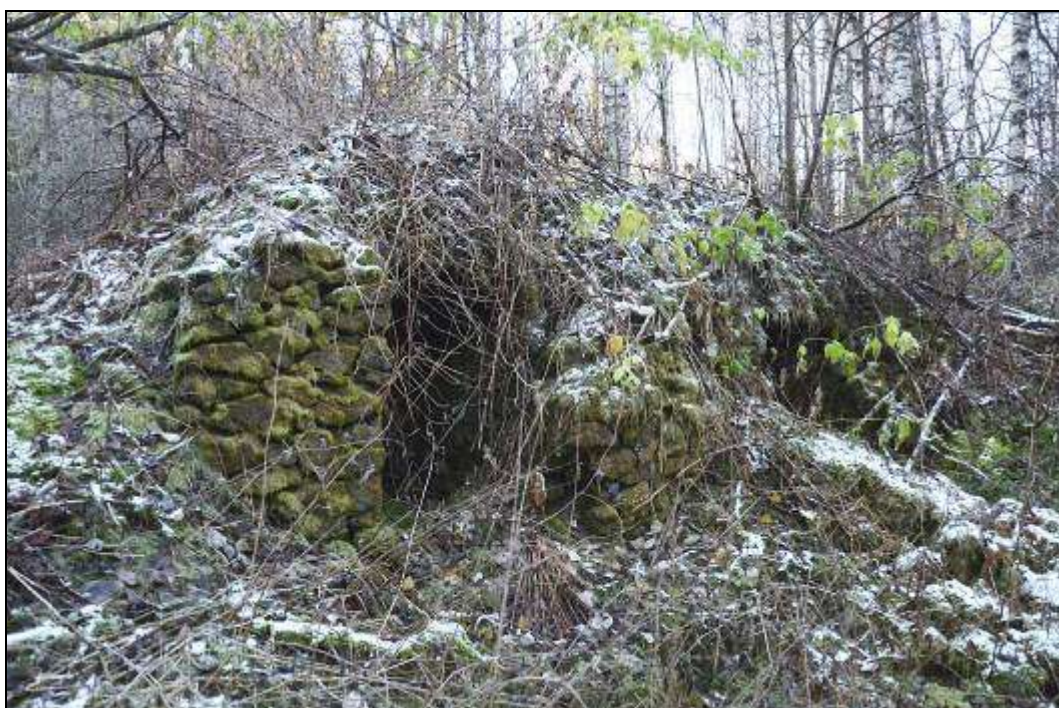
Figur 205. Två öppningar till valvslagna källare av sten i Nedre Aspbo. Foto mot norr.
