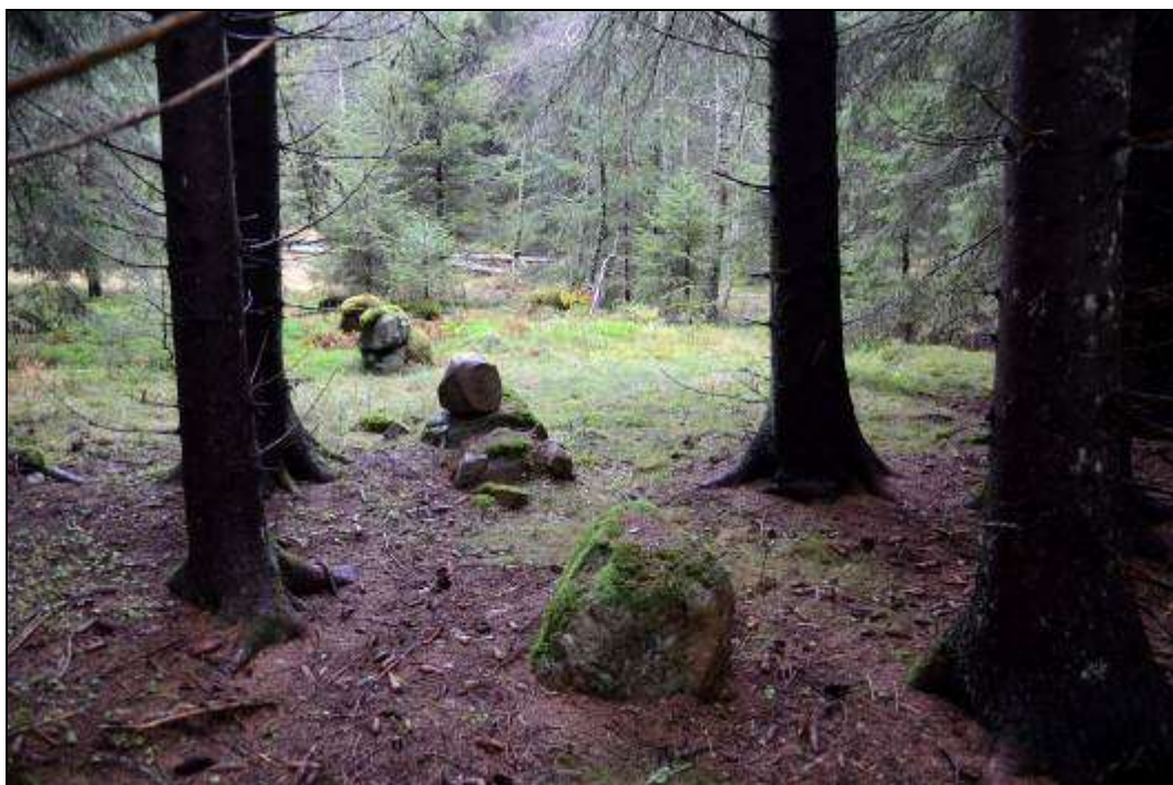
Figur 112. Syllstensrad som bar upp en uthusbyggnad. Foto mot norr.
