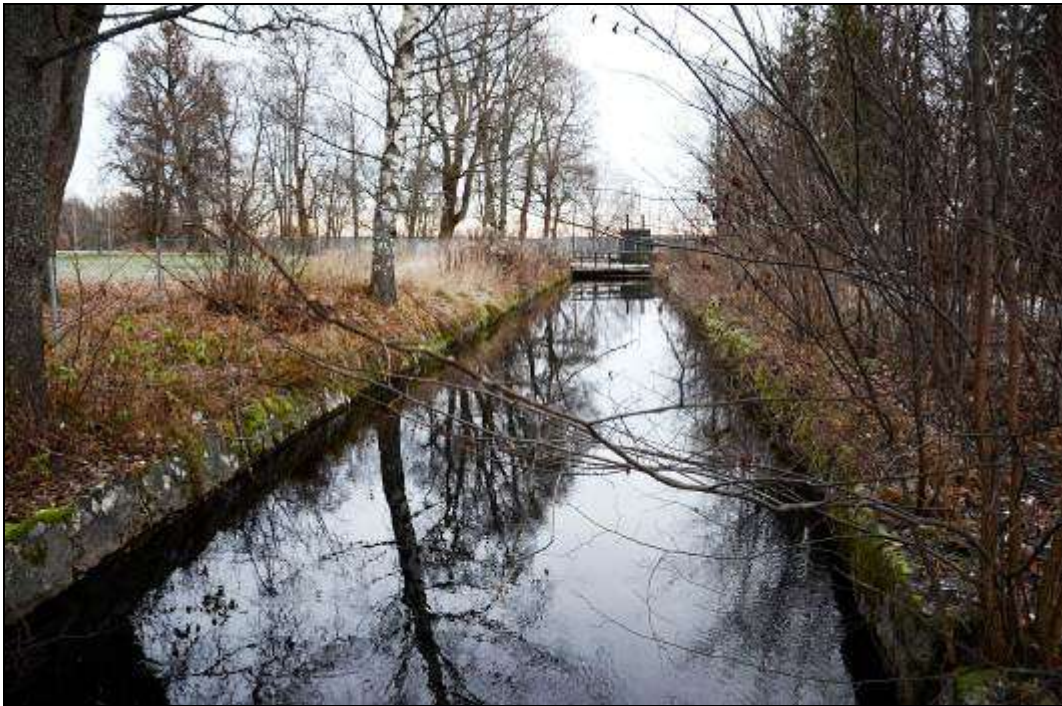
Figur 195. Kanal invid Skinnskattebergs herrgård. Foto mot sydöst.
