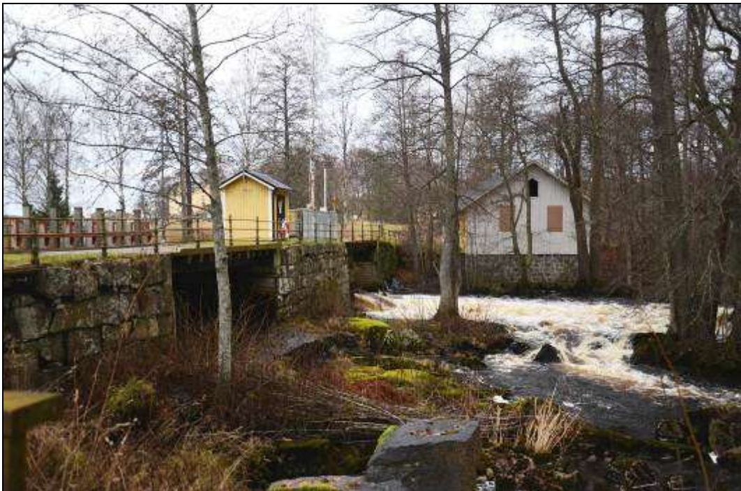
Figur 214. Uttersbergs bruk. På andra sidan bron, på den östra stranden ligger den äldsta delen av Flohammar (Skinnskatteberg 10:1). Foto mot öster.
