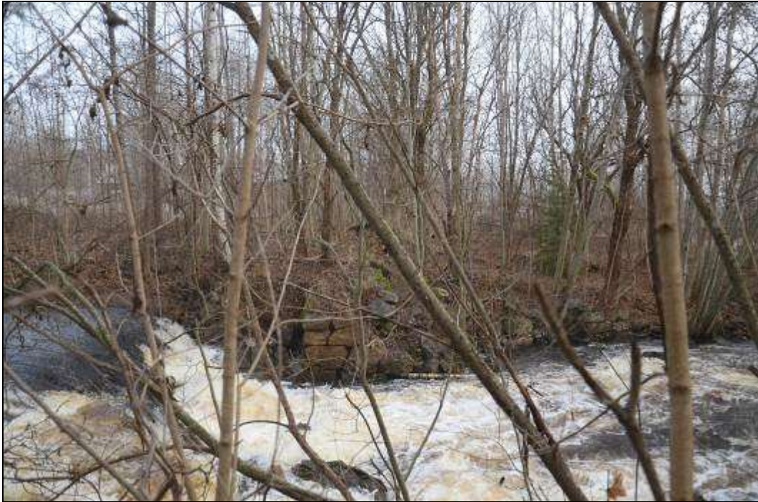
Figur 193. Grunder efter hammare strömmen i Skinnskatteberg. Foto mot öster.
