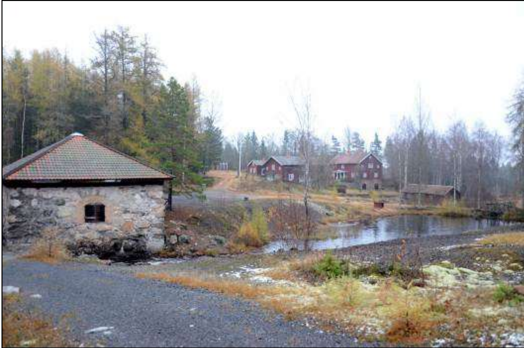
Figur 128. Nya Kopparverket med Kopparboden till vänster i bild. Foto mot sydöst.
