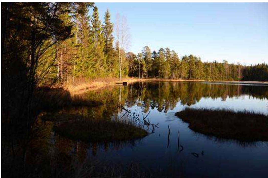
Figur 12. Dämmet vid den stora dammen Paskalampa. Foto mot öster.
