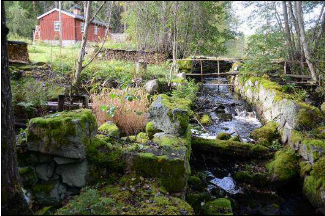
Figur 255. Västra vattenrännan vid Övre hammaren. Foto mot nordväst.
