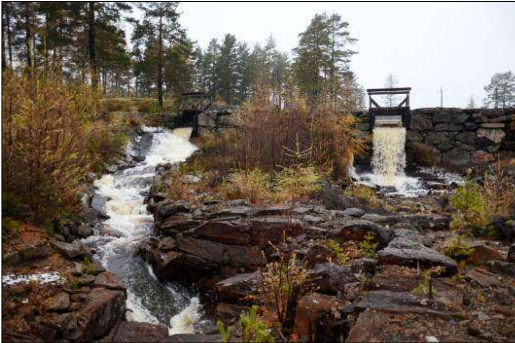
Figur 123. Nya Kopparverket. Damm nr 2. Foto mot norr.
