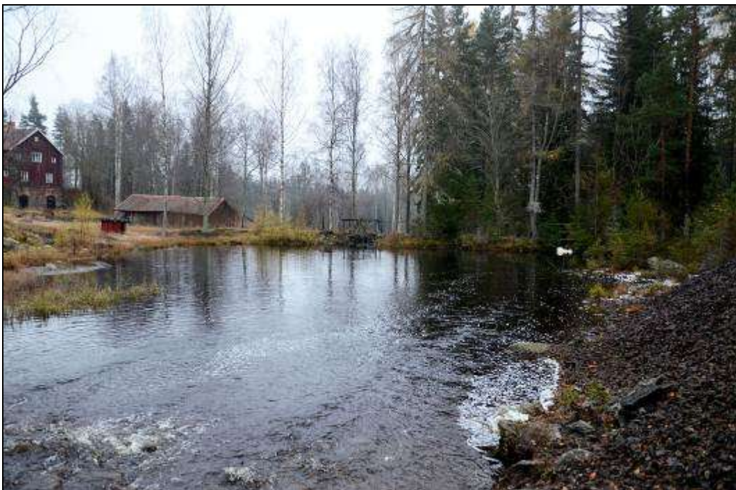
Figur 126. Nya Kopparverket. Upströms damm nr 5. Foto mot söder.
