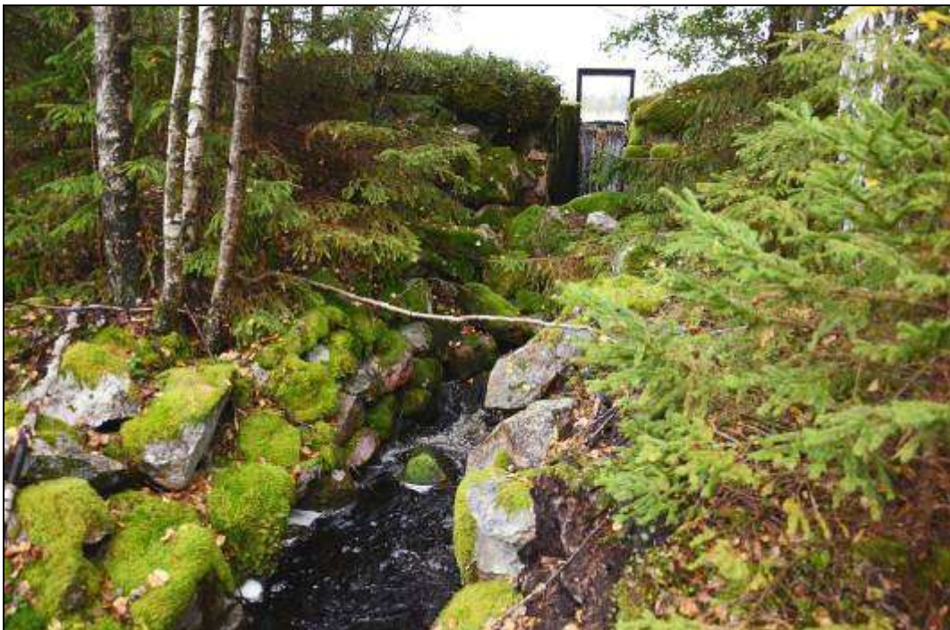
Figur 245. Stensatt vattenränna vid sjön Trehörningens södra utlopp (Västervåla 96:1). Dämnet finns med på en karta från 1698. Foto mot nordväst.
