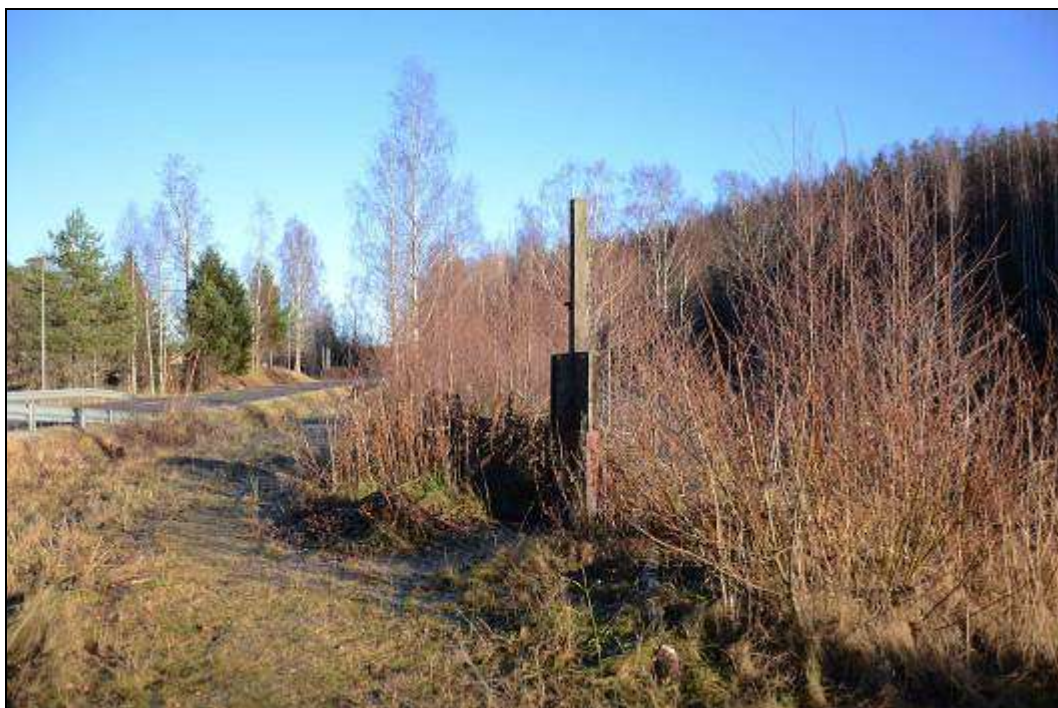
Figur 10. Utskov i Klothyttans damm. Foto mot nordöst.
