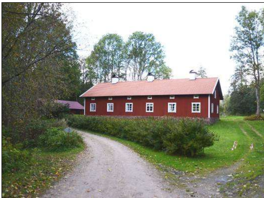
Figur 235. Arbetarlängan. Foto mot nordväst.
