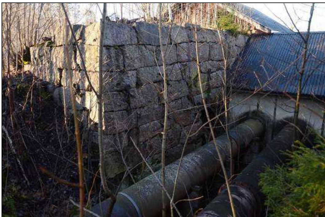
Figur 11. Generationer av vattenverksamhet. Till vänster grund till hyttverksamheten sida vid sida om två vattentuber till kraftverk av senare datum. Foto mot norr.
