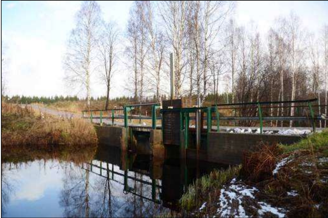
Figur 53. Dämmet uppströms Nedre Borgfors. Foto mot nordöst.
